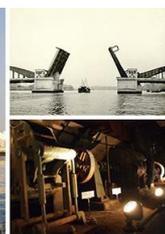
1940(昭和15)年6月開通の、築地と月島を結ぶ、隅田川に架かる可動橋であり、国内最大規模の可動支間(51.6m)を有する。当時盛んであった舟運に対応するために建造され(橋長:246.0m)、2007(平成19)年に重要文化財に指定された。わが国唯一の左右独立跳開機構を有し、可動桁部の重量は片側約1,000t、橋台内部に釣り合い錘(おもり)(約1,000t)が取り付けられ、重心位置にある半径7.4mの歯車と組み合わせられたモーターで駆動する。開閉は交流モーターと直流発電機で制御され、貴重なこれら設備は隣接する旧変電所を改装した「かちどき 橋の資料館」に保存展示されている。竣工以来開橋に関する事故は一度もなく、日本人による設計施工の優秀さを示している。しかし、物資輸送方式の随送への転換、開橋時の交通渋滞、上流に固定桁の佃大橋が建造されたことから、開閉回数は激減、1970(昭和45)年11月29日に開橋を停止した。わが国技術者の努力の現代への伝承のほか、形態の美しさ、文学作品等への登場など、この橋はあまりにも有名である。
