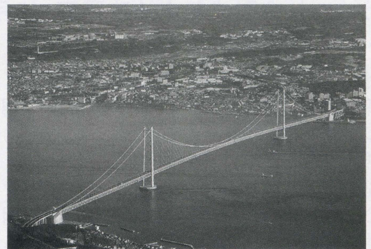
図6 明石海峡大橋
